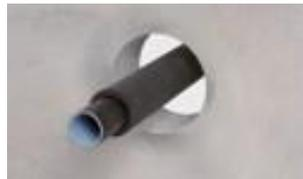
Vedere ETA-20 / 0993 per l'elenco con i marchi dei tubi, le dimensioni e le dimensioni isolamento, per trovare la classe di resistenza al fuoco ottenibile con la benda antifluoco CFS-B
