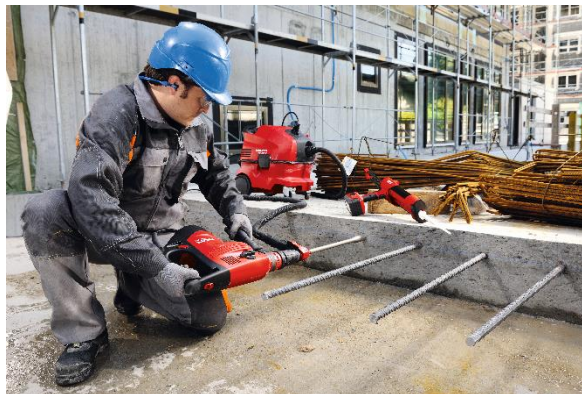
Figura 15 – Perforazione con un trapano Hilti a roto-percussione munito di tecnologia SafeSet™
