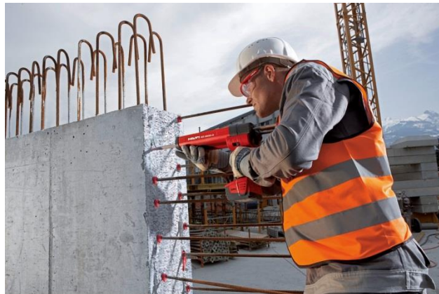
Figura 2– Iniezione di resina adesiva Hilti HIT in un foro praticato con dispenser ED 3500-Ato per semplificare l'installazione di ferri di ripresa post-installati.
