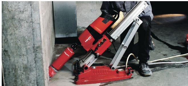
Figura 17 – Perforazione a corona diamantata inclinata con telaio Hilti.
