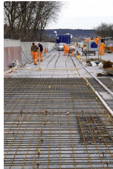
c. Incremento dello spessore di un impalcato di ponte
