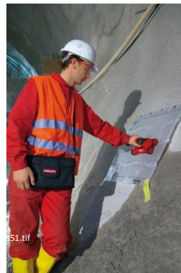
Figura 10 – Uso di uno scanner Hilti PS 200 Ferrosan per individuare e mappare armature esistenti prima della perforazione
