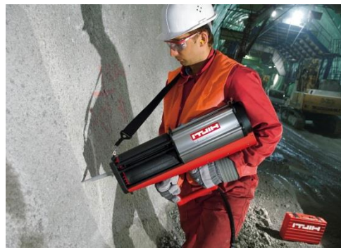
Figura 25 – Il dispenser pneumatico Hilti HIT-P8000D, indicato per installazione di grandi volumi con ferri di diametro largo.
