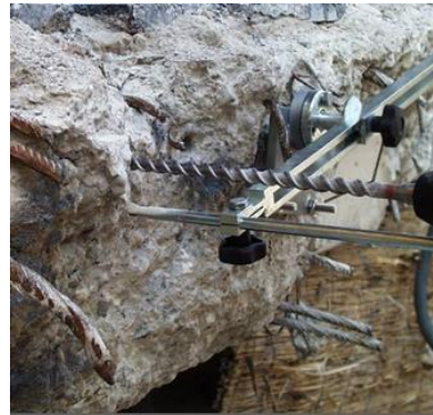
Figura 14 – Perforazione con guida di perforazione
