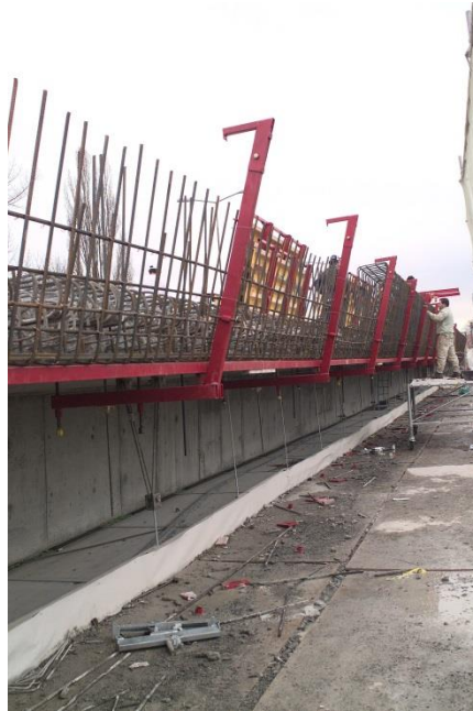
a. Ampliamento della larghezza di un ponte
