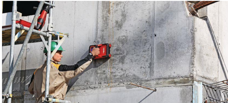
Figura 4– Scansione per la ricerca di ferri di armatura e altri elementi immersi nel calcestruzzo mediante scanner GPR Hilti.
