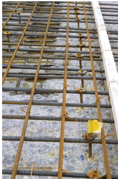
c. Incremento dello spessore di un impalcato di ponte
