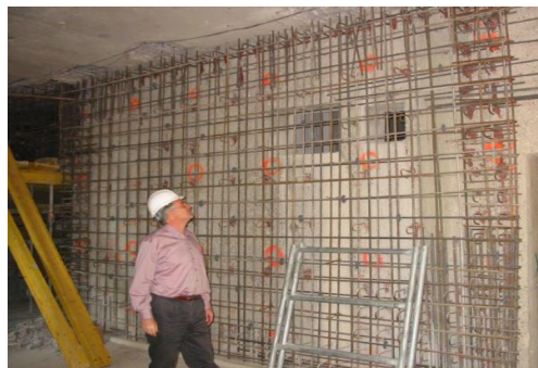
c. Parete rivestita con strato di calcestruzzo proiettato
