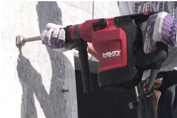
Figura 12 – Irruvidimento di una superficie di calcestruzzo con perforatore combinato Hilti TE 76
