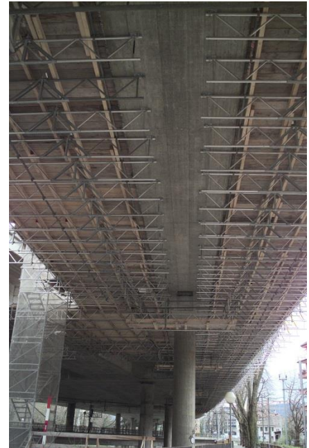
b. Recupero di un impalcato di ponte
