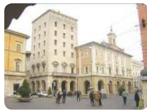
Studi sulla mitigazione della risposta sismica di costruzioni esistenti e nuove mediante dispositivi, sistemi e configurazioni innovative. Il caso della torre civica di Rieti
