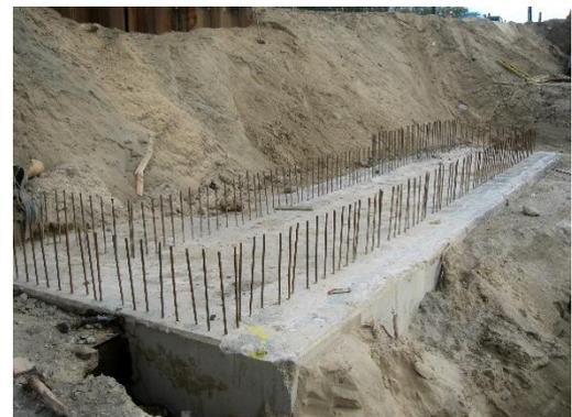
c) Struttura della spalla con armature post-installate
