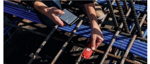
Figura 9.20. Sensore per calcestruzzo Hilti (wireless) che trasmette dati in tempo reale sulla temperatura, la resistenza e l'umidità relativa del calcestruzzo all'applicazione mobile dei sensori per calcestruzzo
