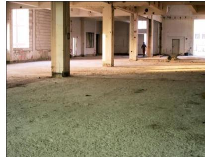
b) Superficie irruvidita del solaio
