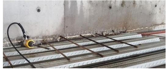
b) Installazione di armature post-installate per il collegamento tra lastra e parete
