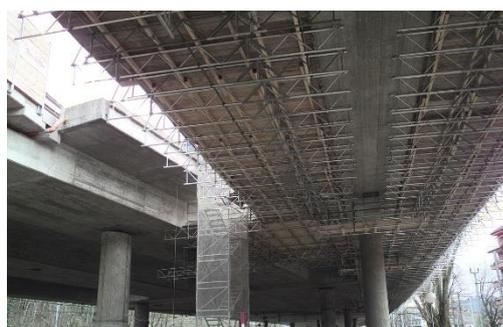
c) Aumento della sezione della trave di un ponte
