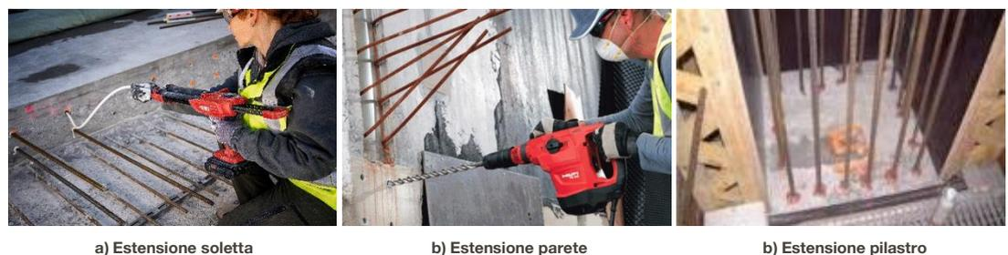
Figura 2.3. Esempi di estensione di elementi in calcestruzzo mediante sovrapposizione di armature post-installate
