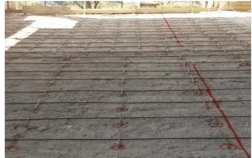
f) Rinforzo soletta tramite ringrosso della sezione
