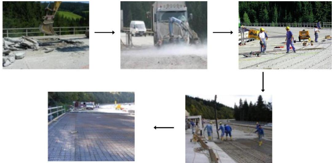
Figura 9.18. Sequenza di costruzione di un ringrosso di calcestruzzo su un implacato da ponte (sequenza di immagini in senso orario)
