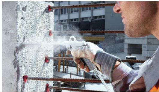
a) Soffiaggio dell'aria per asportare polvere dai fori
