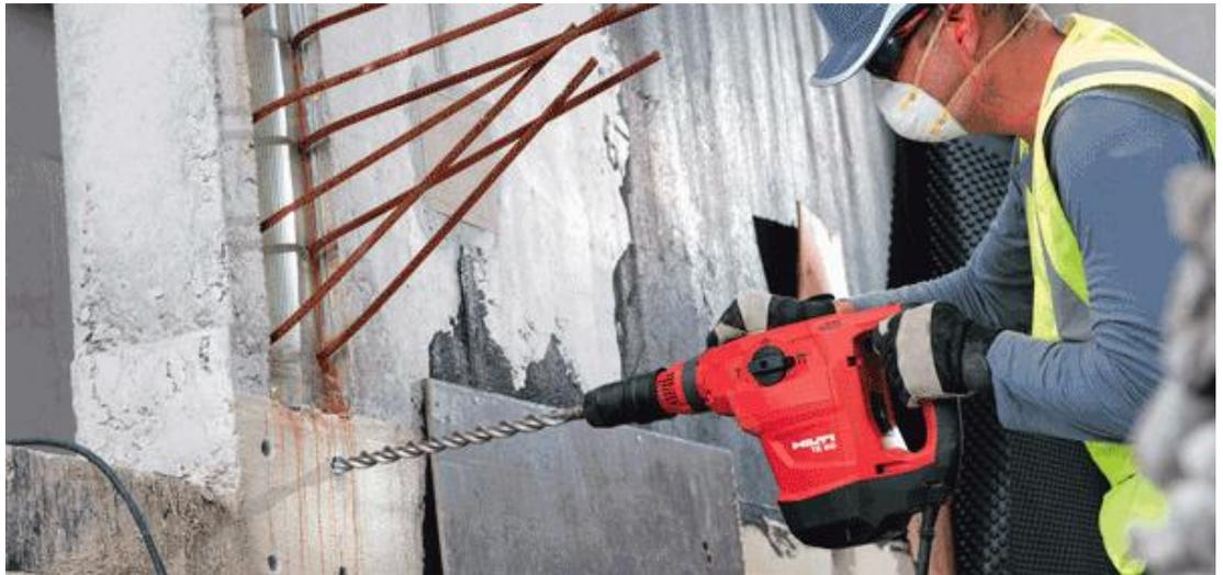
Figura 9.4. Esempio di foratura a percussione (HD)
