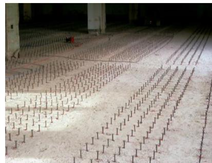
c) Rinforzo del solaio con connettori a taglio HCC-K
