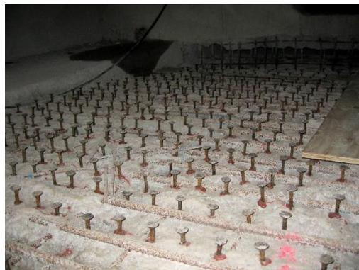
b) Rinforzo della trave scatolare del ponte con connettori HCC-K
