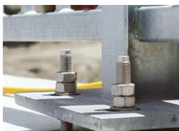
**Fissaggio della barriera di sicurezza**
