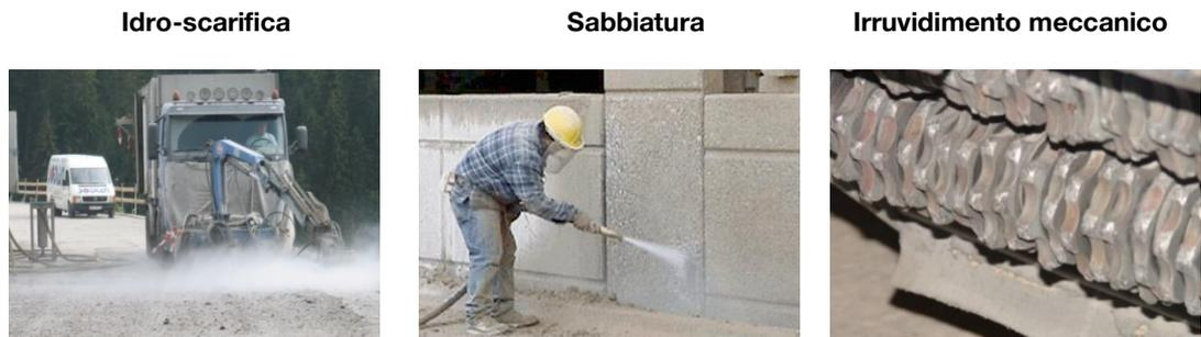
Quando si specifica il trattamento superficiale si raccomanda di specificare la rugosità media  $R_t$  desiderata invece del solo metodo d'irruvidimento in modo da garantire la prestazione definita in fase progettuale. Prima di approvare il trattamento è necessario creare una superficie campione e controllarla con il metodo del *sand-patch* [17]. Un'indicazione della scabrezza superficiale è riportata nella Tabella 7.
