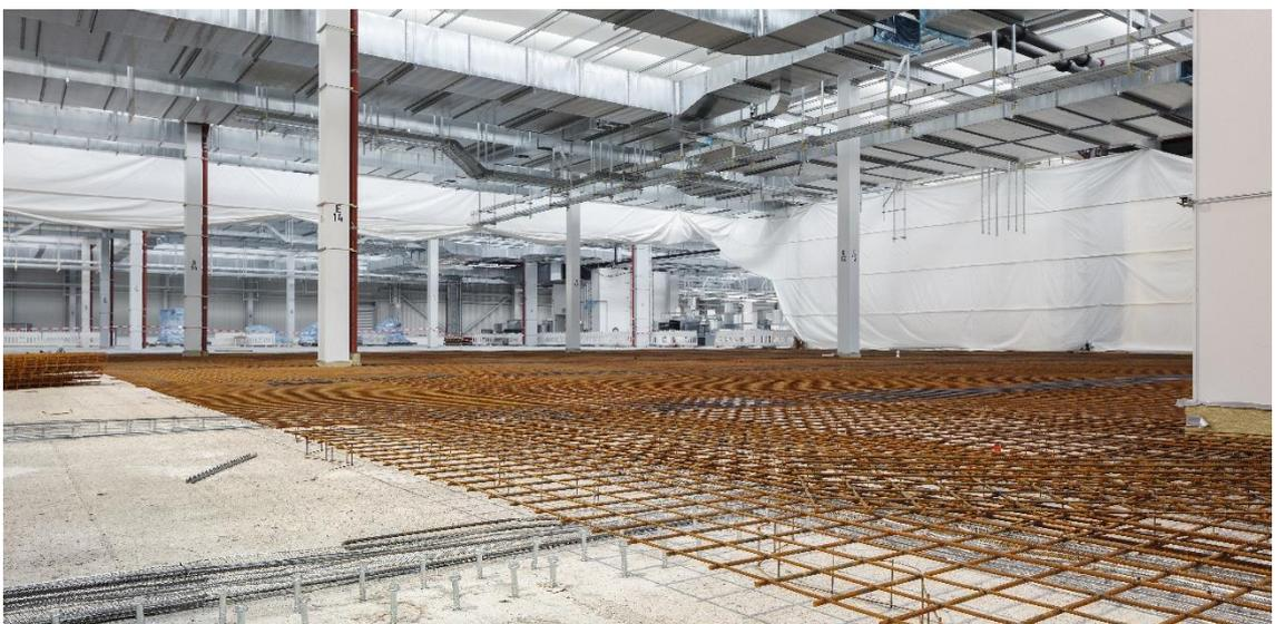
Figura 1. Un'applicazione tipica di sovrapposizione di strati calcestruzzo (*Overlay*) in ingegneria civile è il rinforzo o il risanamento di pavimentazioni industriali.
