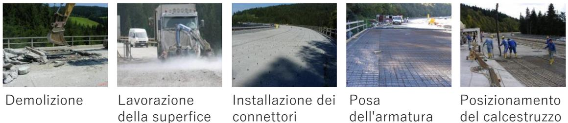
Figura 5. Panoramica semplificata delle fasi di esecuzione di una misurazione di costruzione con sovrapposizione.
