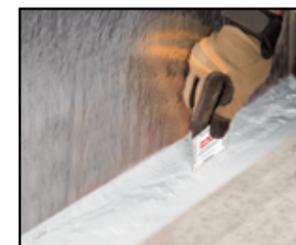
Controllare che lo spessore dello strato umido sia 3-5 mm (2 mm asciutto).
