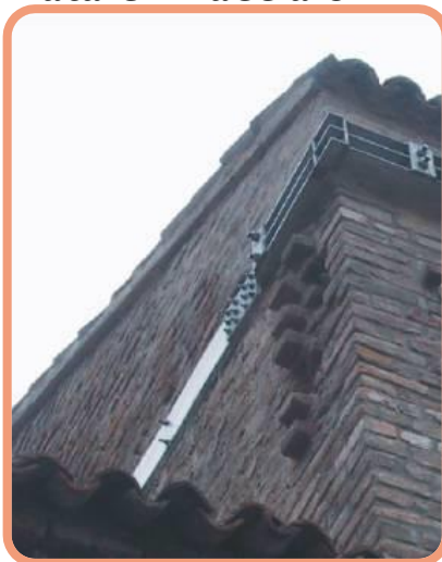
Cordolature in muratura armata e in acciaio
