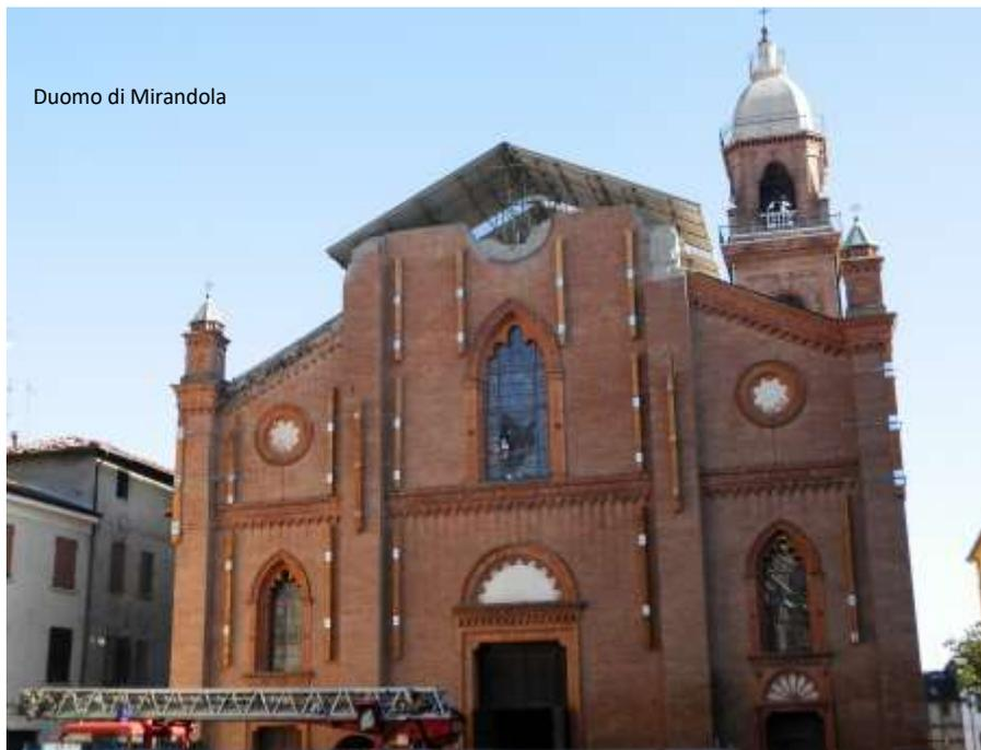
Dal maggio 2012 il duomo di Mirandola è chiuso a causa dei gravissimi danni causati dal [terremoto dell'Emilia del 2012<sup>\[7\]</sup>](#), stimati in circa **5.875.000 euro**. In particolare, a seguito delle numero scosse telluriche la copertura lignea sorretta da capriate è crollata causando il collasso delle volte interne, la cui macerie hanno sepolto e distrutto in maniera gravissima gli interni della chiesa.
