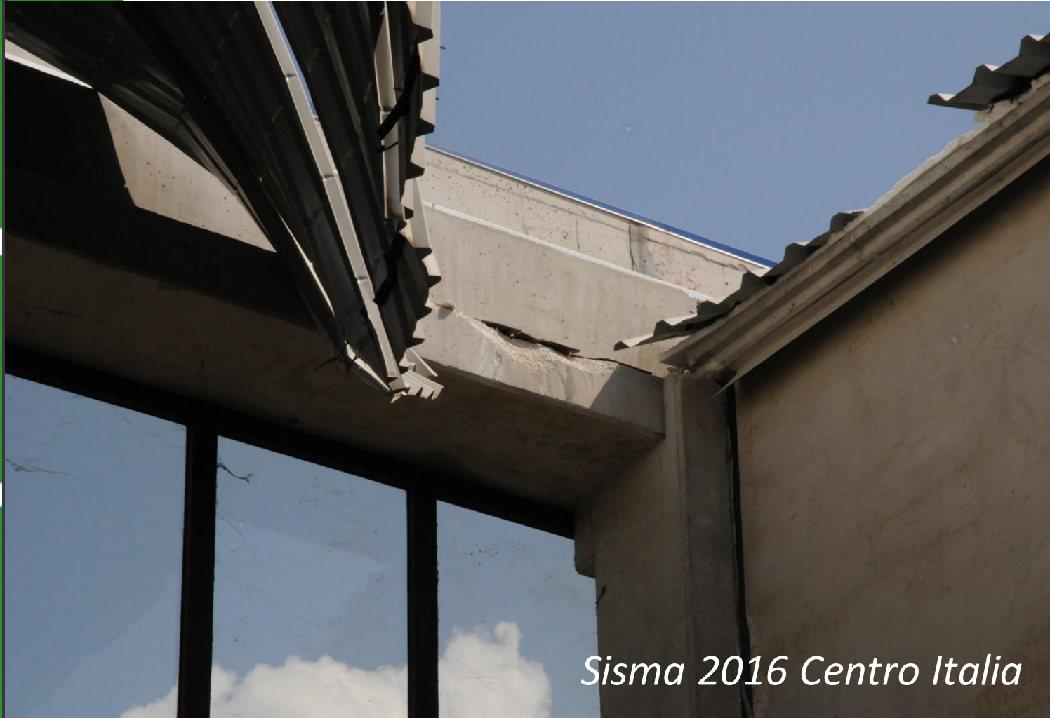
Rottura della connessione tegolo - trave
