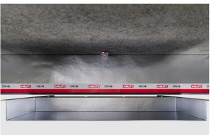
La sezione di CFS-NVB deve essere centrata con la cavity barrier ventilata CFS-VB una volta installato il pannello.
