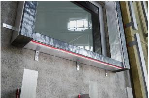
Qualora la presenza della finestra non permettesse l'installazione delle mensole di supporto delle cavity barrier al di sopra delle barriere è possibile fissare le mensole al di sotto.
