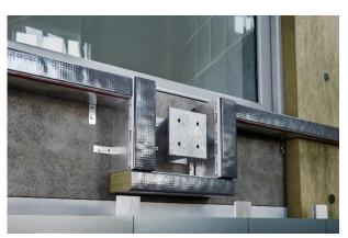
Quando la linea delle cavity barrier è interrotta da staffe di supporto per balconi, incapsulare le staffe con barriere non ventilate CFS-NVB verticalmente e barriere ventilate orizzontalmente CFS-VB.
