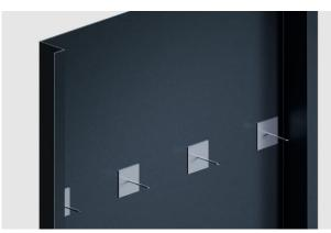
Installare perni isolanti autoadesivi all'interno del pannello a cassetta. Assicurarsi che si trovino lungo la linea della barriera antincendio.
