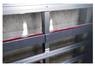
In alternativa, quando la guida della facciata interseca parzialmente il bordo anteriore della barriera, intagliare la barriera per includere la guida e fissare il materiale intumescente alla parte anteriore della guida.
